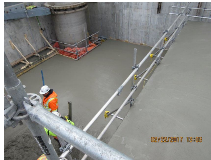
Roof Concrete Pour
