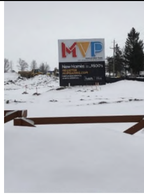
MVP Subdivision Construction
