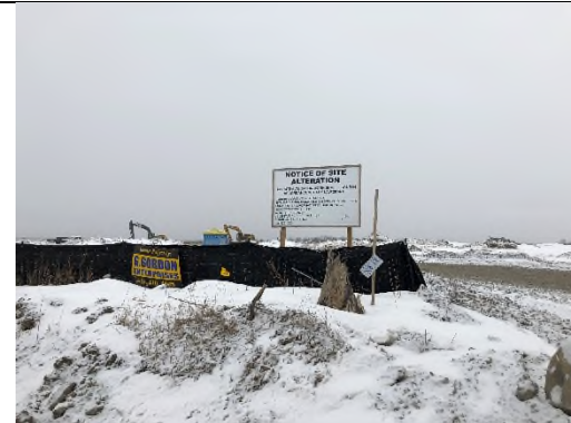
EMG Barrie GT Inc. Subdivision Construction
