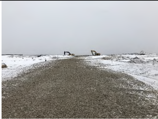
EMG Barrie GT Inc. Subdivision Construction
