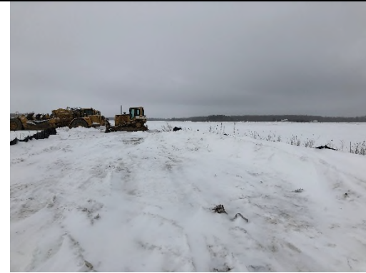
Watersand Subdivision Construction
