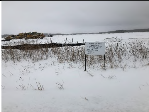
Watersand Subdivision Construction
