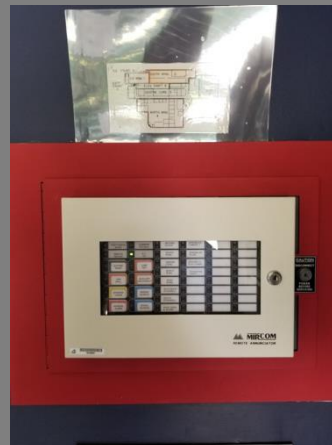
Fire Alarm Annunciator
