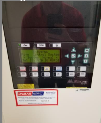
Fire Alarm Annunciator
