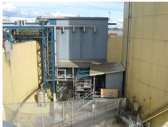
LNG Plant Upgrade
